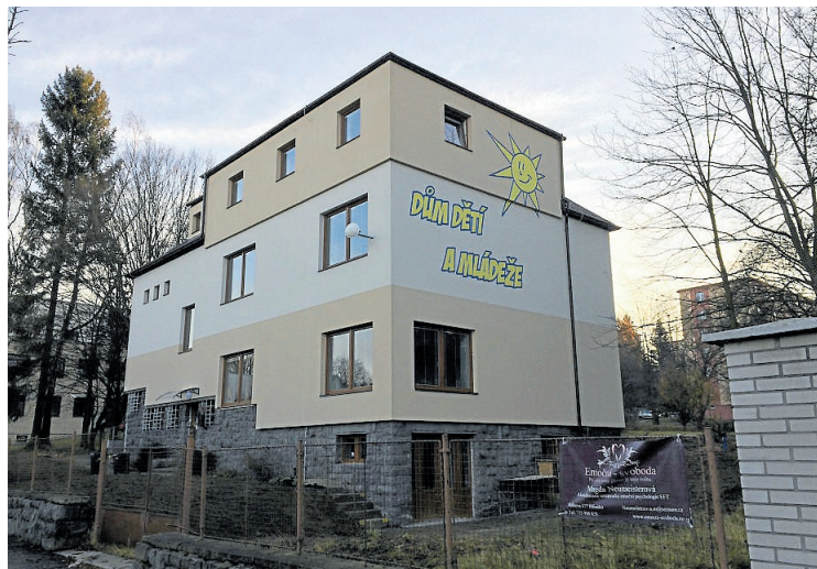
Dostavba a rekonstrukce Domu dětí a mládeže, 9 mil. Kč.
