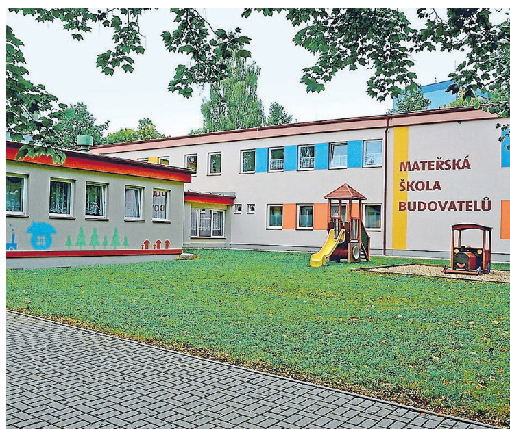
Rekonstrukce vnitřní instalace a soc. zařízení MŠ Budovatelů, 3,3 mil. Kč.
