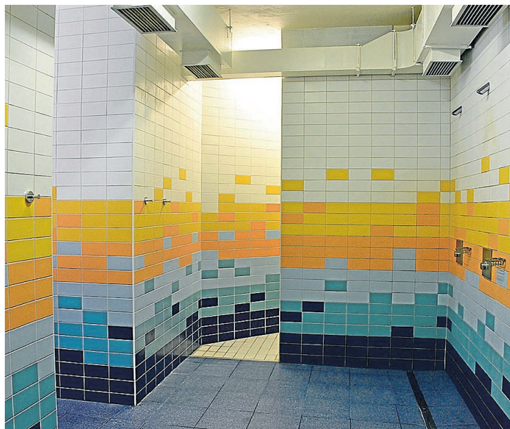
Plavecký bazén, rekonstrukce sprch, 1,825 mil. Kč.
