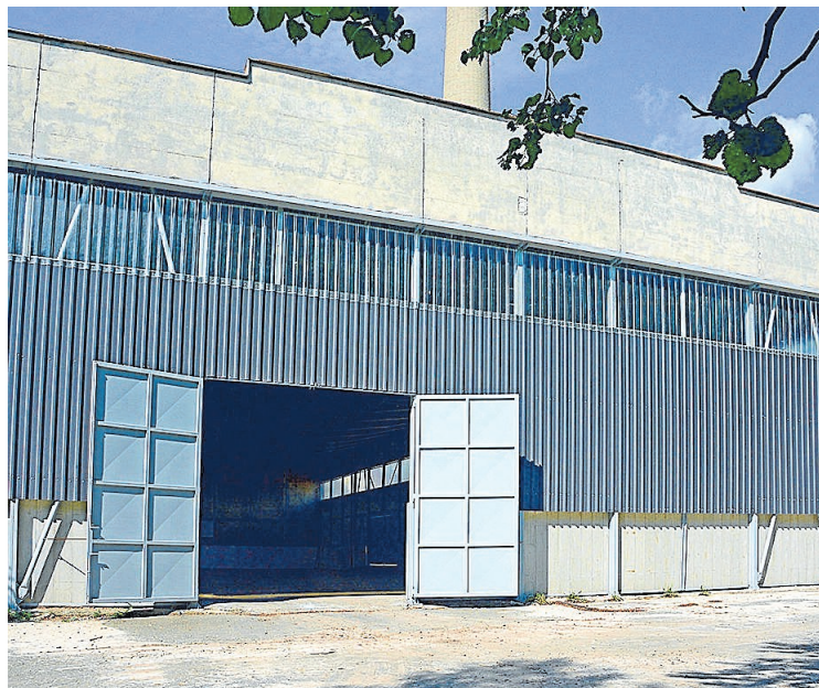
Rekonstrukce bývalé uhelny hlinecké teplárny, 2, 4 mil. Kč.
