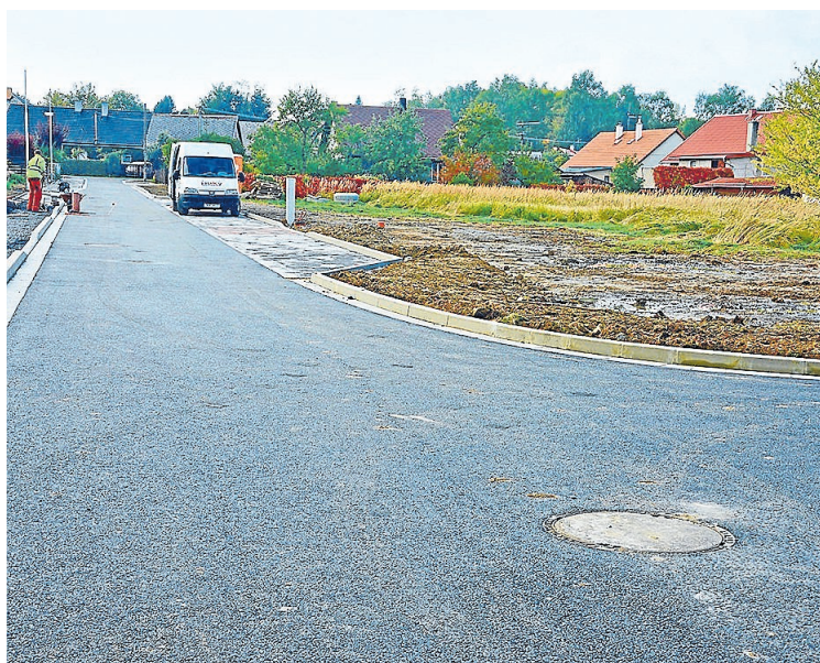
Srni-zasíťování pěti nových stavebních parcel, 3,7 mil. Kč.
