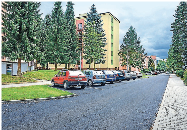
Rekonstrukce ulice Budovatelů, 4,26 mil. Kč.
