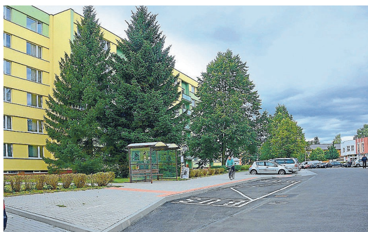
V letošním roce proběhla kompletní rekonstrukce ulice Družstevní.
