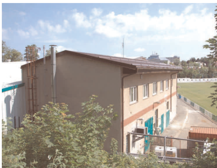
Oprava střechy přístavby zimního stadionu
