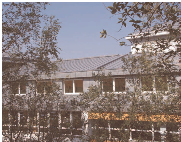
Oprava střechy ZŠ Ležáků
