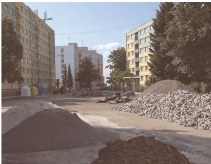
Rekonstrukce Družstevní ulice
