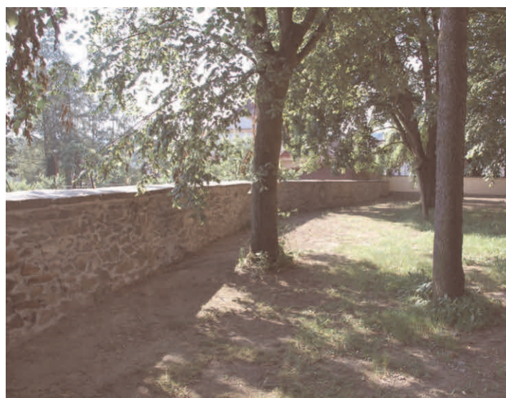
Hřbitov - oprava kamenných zdí a nové oplocení
