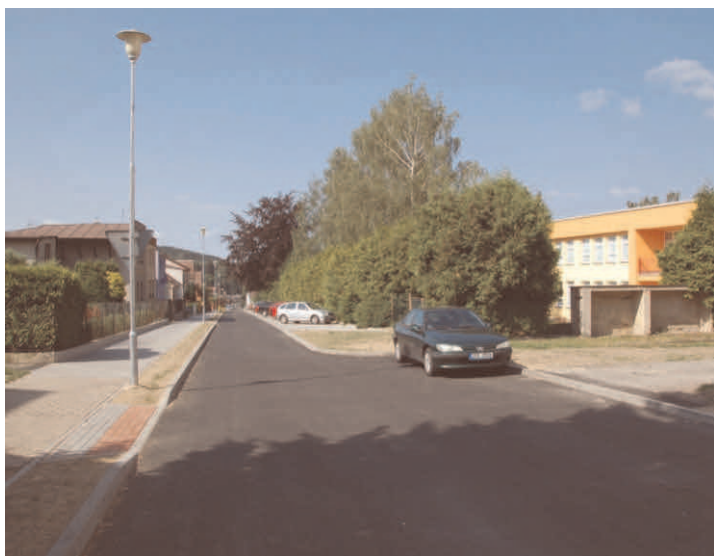
Rekonstrukce ulice Čechova
