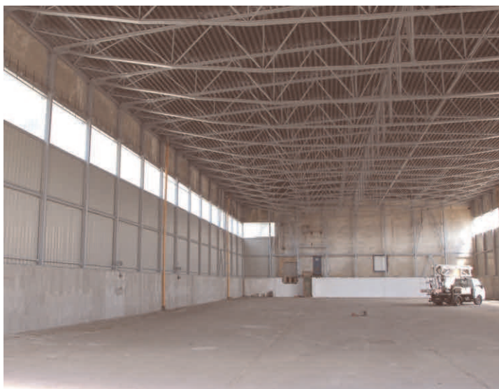
Rekonstrukce haly v teplárně
