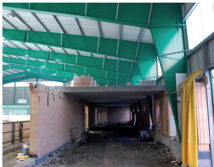
Dostavba zimního stadionu 5 000 000 Kč
