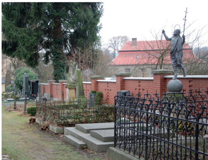
Oprava hřbitovní zdi 1 090 000 Kč
