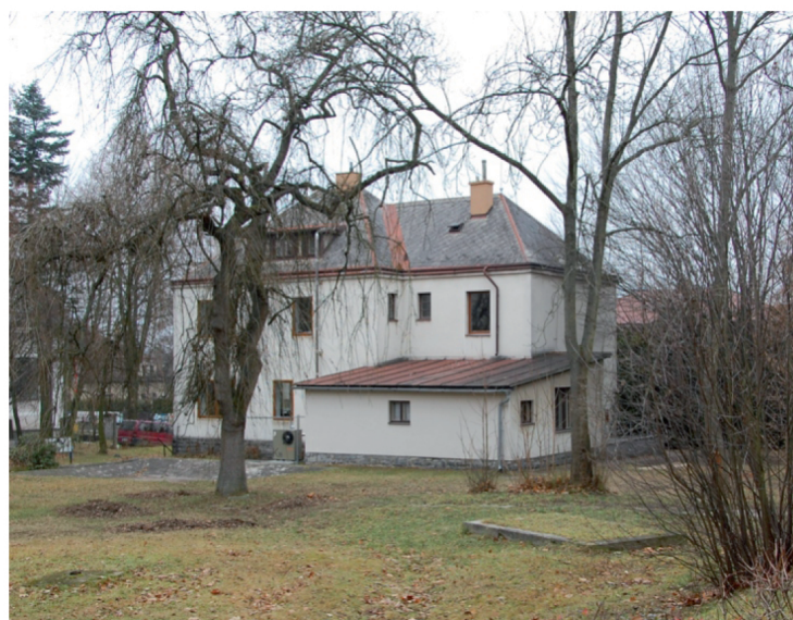
Rekonstrukce DDM I. etapa 3 129 000 Kč
