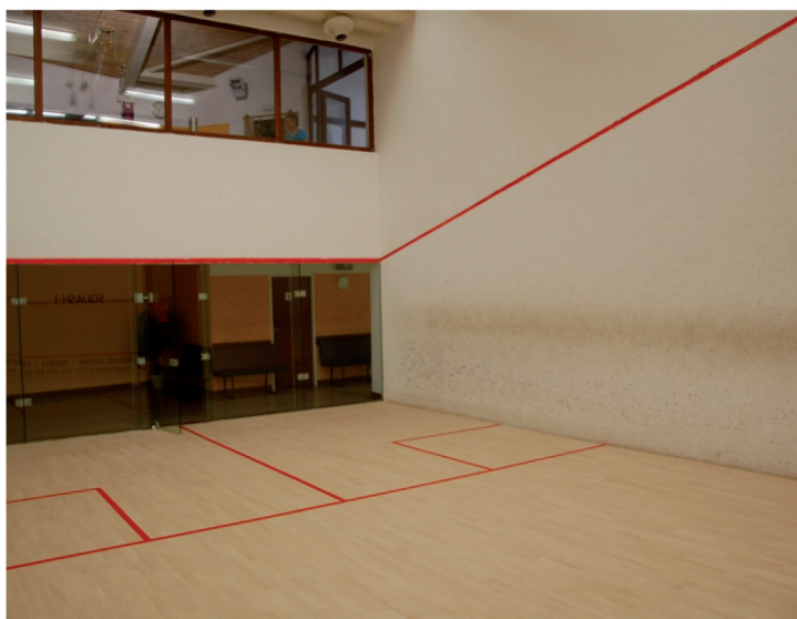
Oprava squashového kurtu, WC 635 000 Kč
