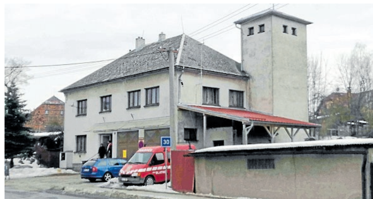
HASIČSKÁ ZBROJNICE V BLATNĚ je v neutěšeném stavu. Máme připravený projekt rekonstrukce včetně stavebního povolení.
